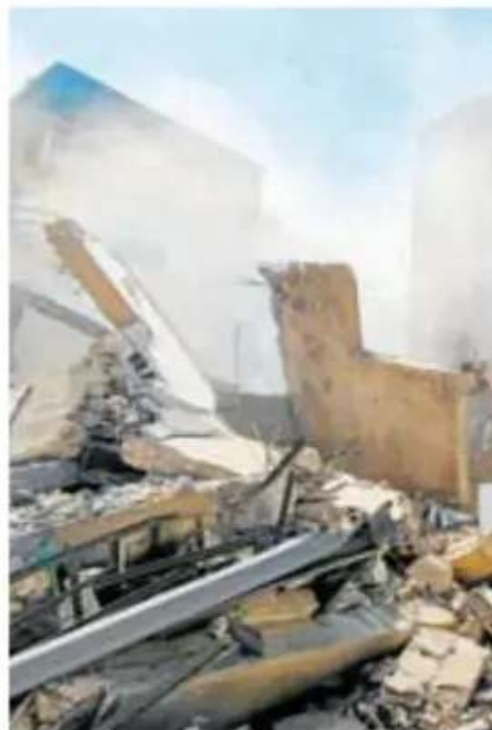
Edificio destruido tras un ataque. EP
