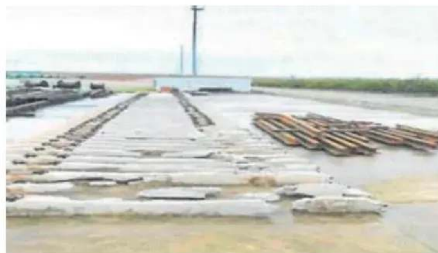
Carriles de las vías de la zona del siniestro retiradas por Adif. ABC
