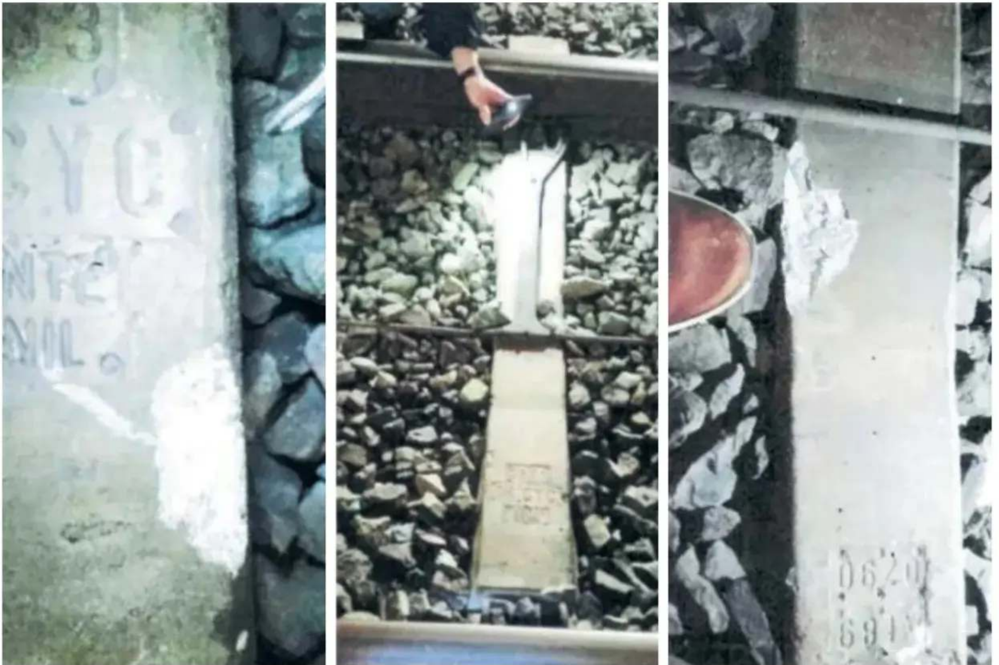
Tres de las imágenes del informe que Adif trasladó a la juez con los daños visibles en las traviesas. ABC
