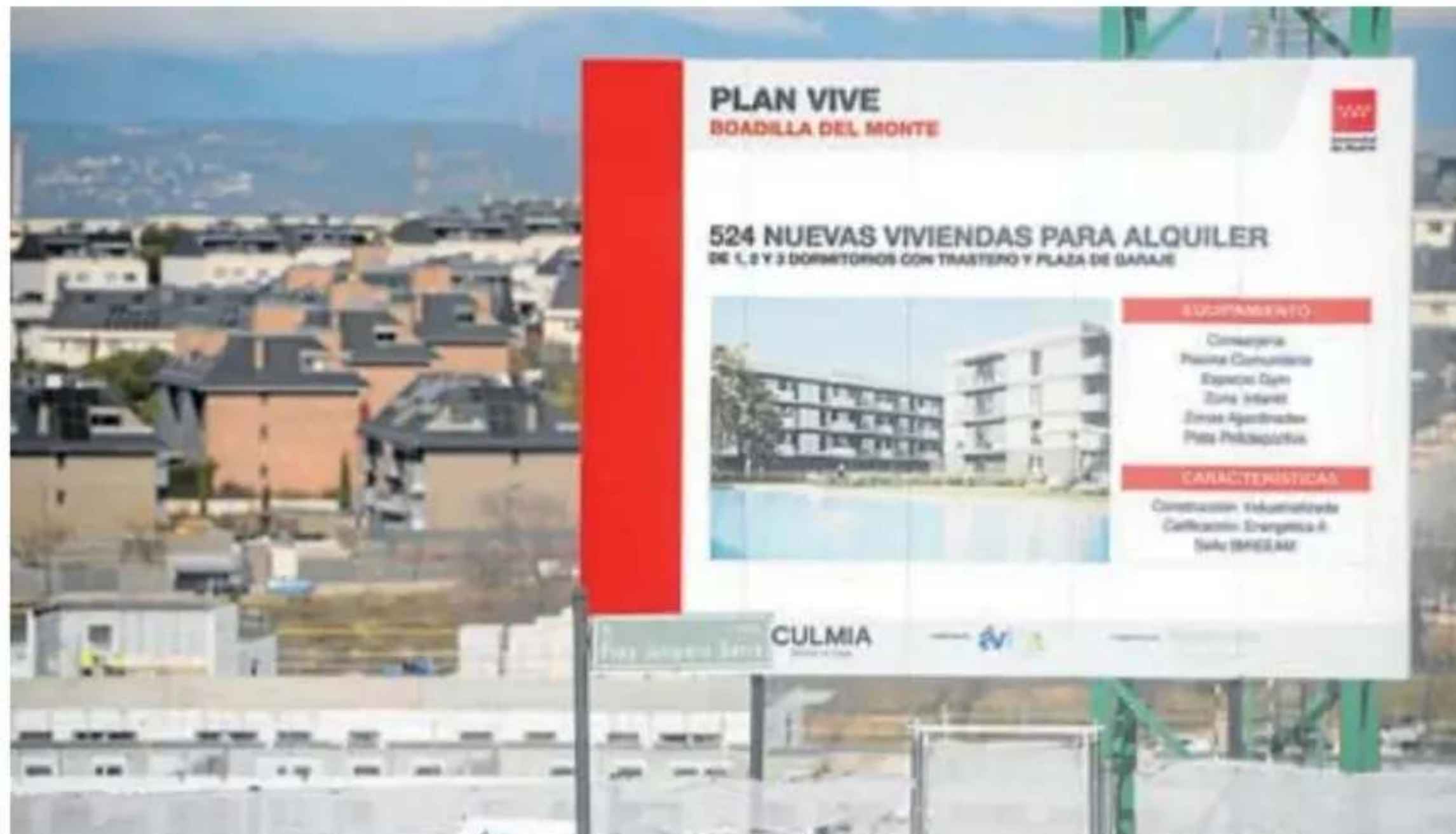
Construcción de viviendas del Plan Vive en Boadilla del Monte (Madrid). Belén Díaz
