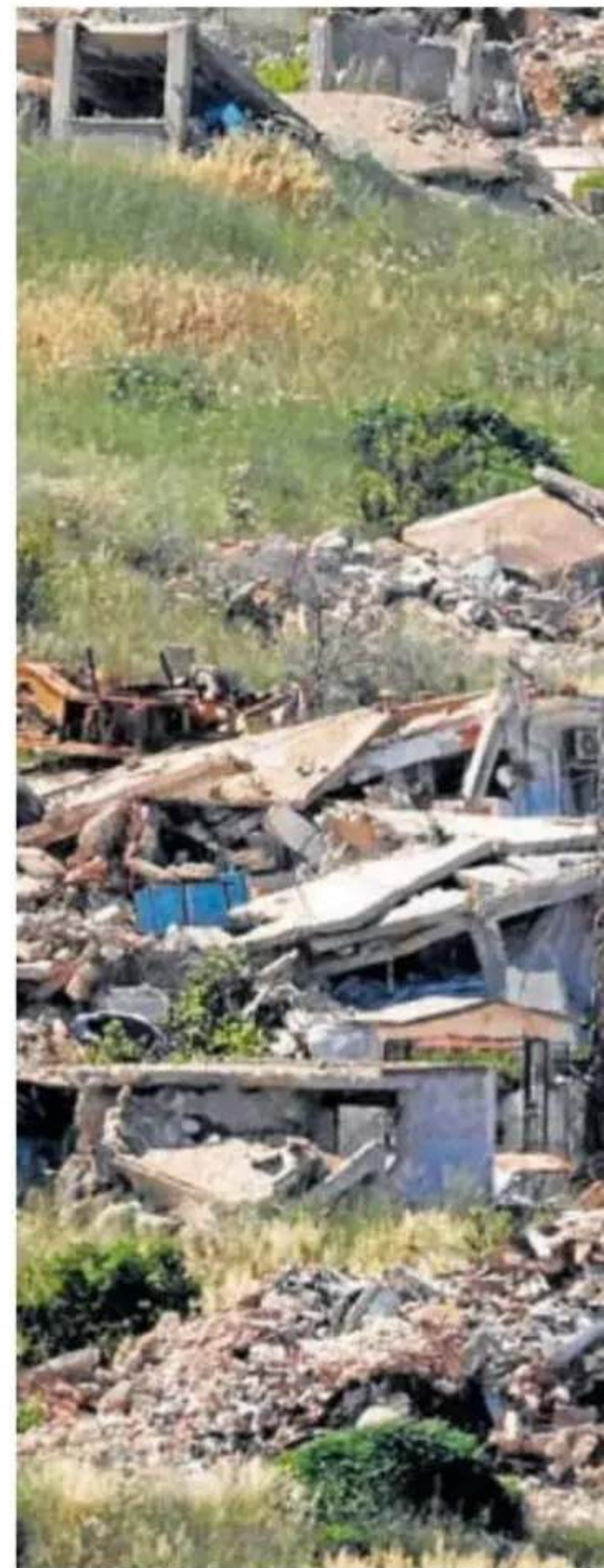
Una bandera israelí ondea sobre un edificio destruido en la aldea libanesa de Kfar Kela. Afp
