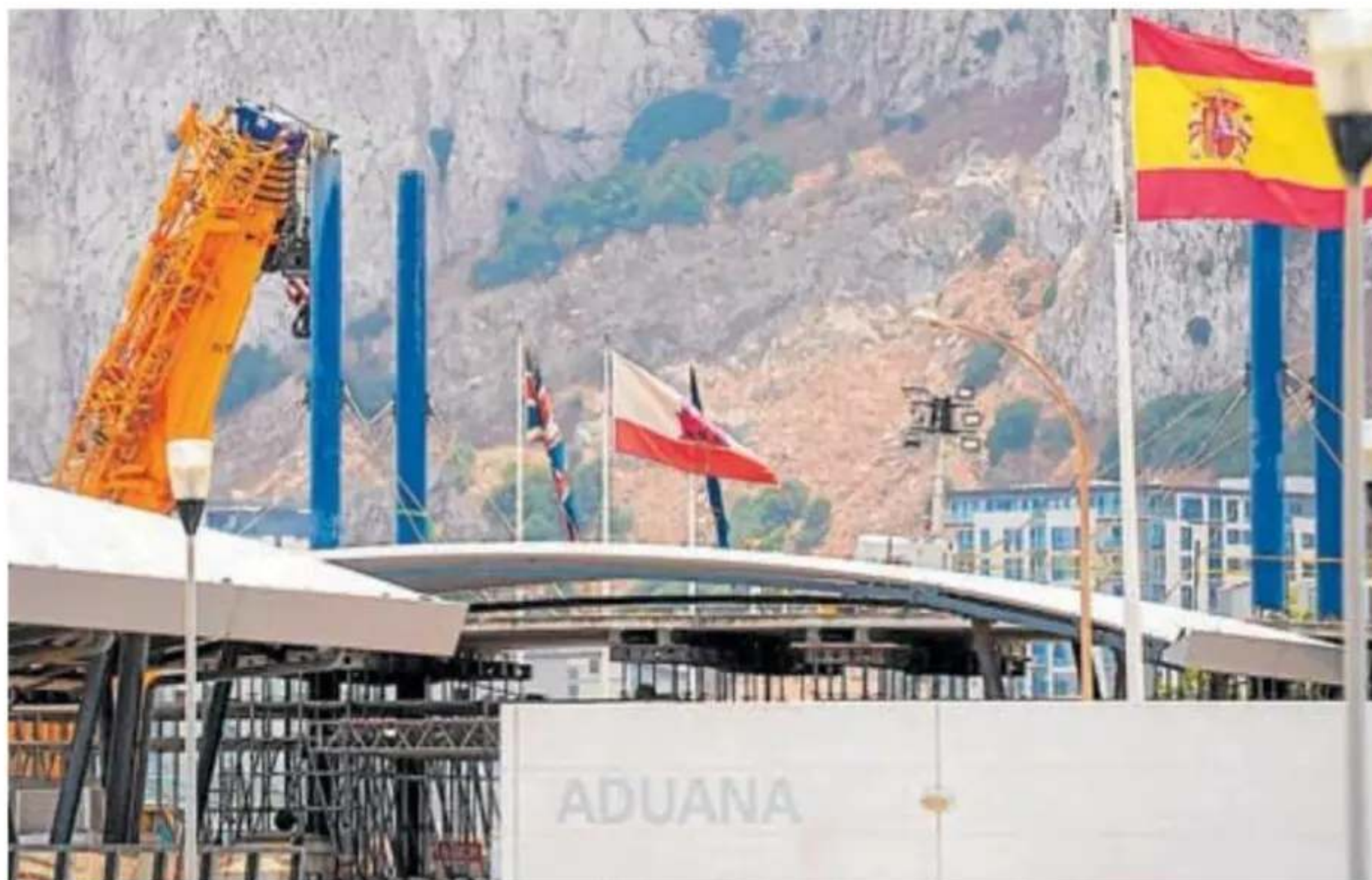
Maquinaria instalando andamios para el desmonte de la histórica verja de Gibraltar. EP
