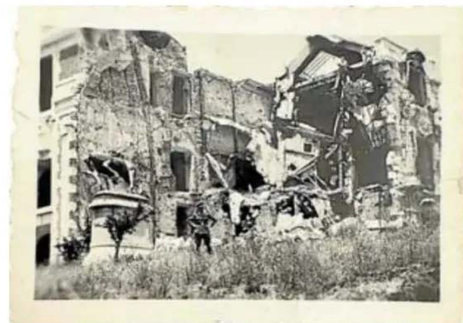
Un militar ante el edificio de la Casa de Velázquez destruido.
